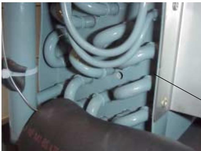
Ниша на испарителе для размещения датчика
